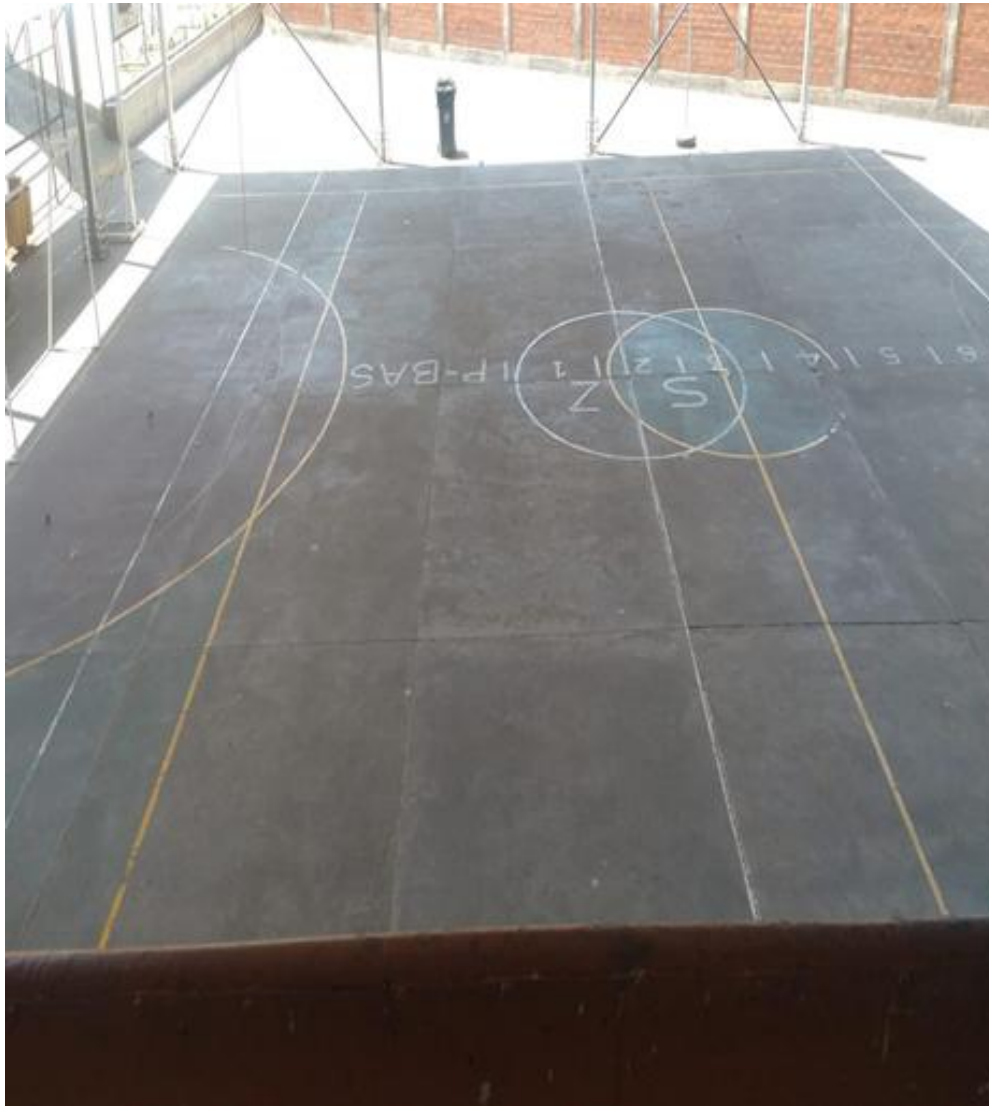
Fotografía Zona de Seguridad
